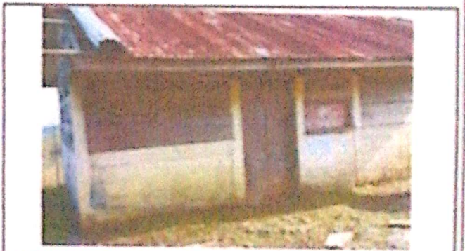
Foto 4: repacion y ampliacion de cocinas
