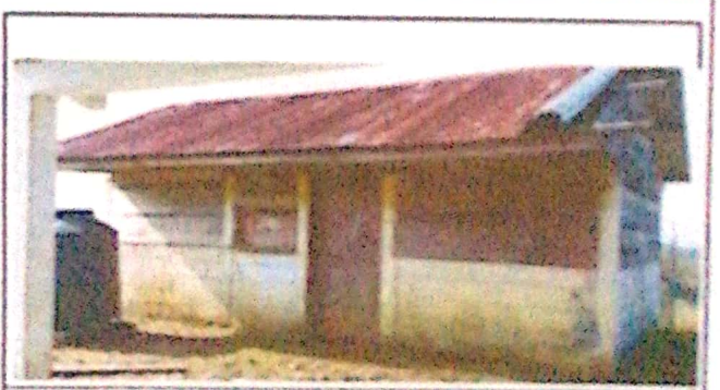
Foto 6: sustitucion de madera
