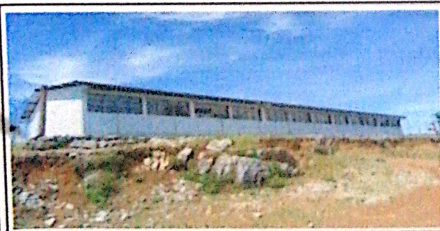
Foto 5: cambio de pintura
