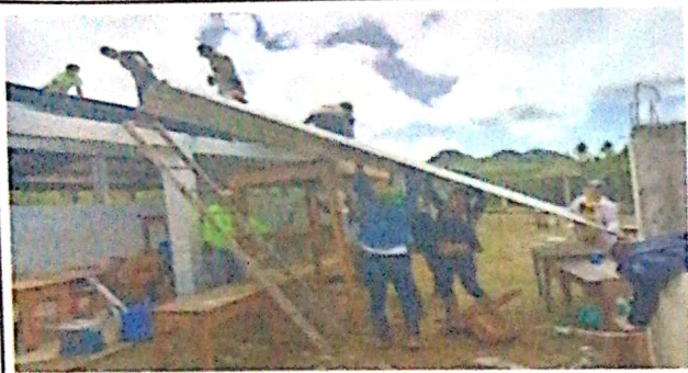
Foto1: cambio en techado
