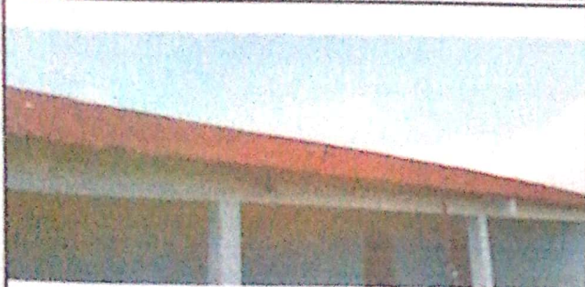
Foto 1: Sustitucion de lamina
