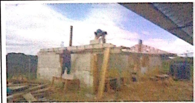
Foto 4: ampliacion de cocina
