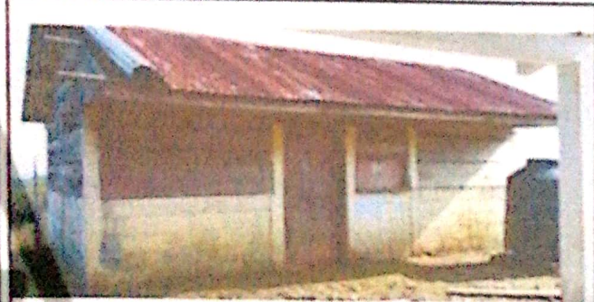
Foto 3: Sustitucion de puerta
